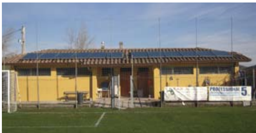
Impianto solare termico e caldaia a metano, al campo sportivo
